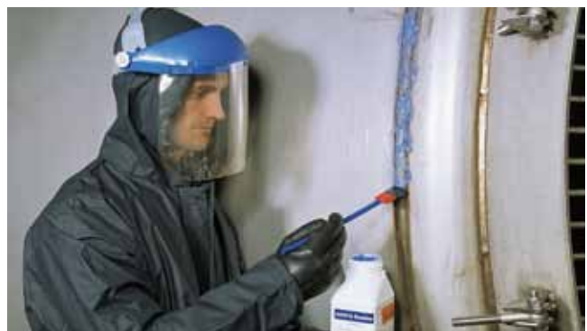
Nanoszenie środka trawiącego pędzlem
